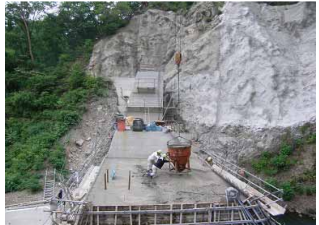
図 3 (コンクリート打設状況)
