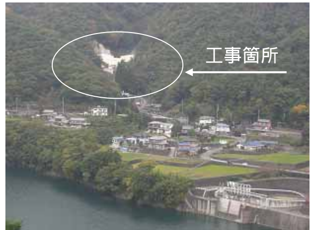
図 1 (工事現場の全景)
