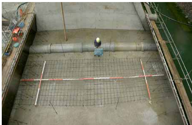
図 5 (ひび割れ抑制筋の配置状況)
